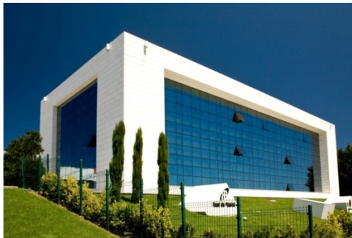
Figura 3.5: Edificio de oficinas, junto a la S-20 en Santander, promovido por Real de Piasca, y donde tiene su sede ésta firma.
