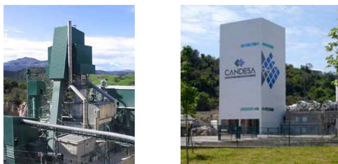
Figuras 5.1: Instalaciones de Dolomitas del Norte SA (izda.) en Castro Urdiales y de Canteras de Santander SA (dcha.) en Camargo.
