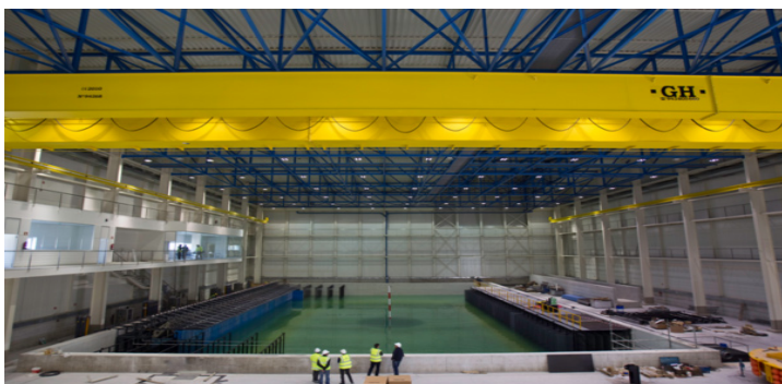
Figuras 4.10: Instalaciones del Instituto de Hidráulica Ambiental de Cantabria (arriba) y del Gran Tanque de Ingeniería Marítima (abajo), en el Parque Científico y Tecnológico de Cantabria (PCTCAN), en Santander.
